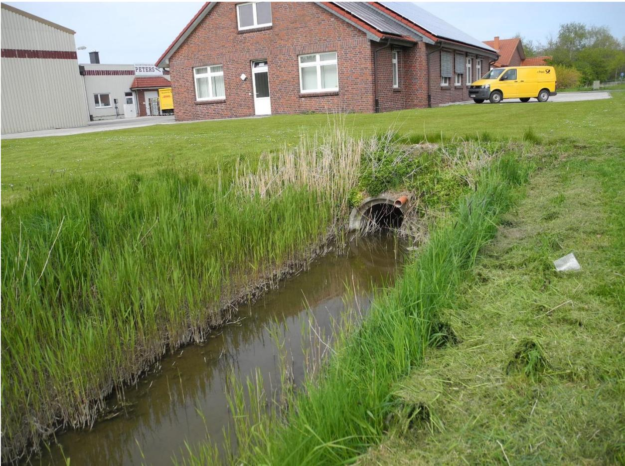
Abbildung 7: Drainagerohr oberhalb der Grabenverrohrung
