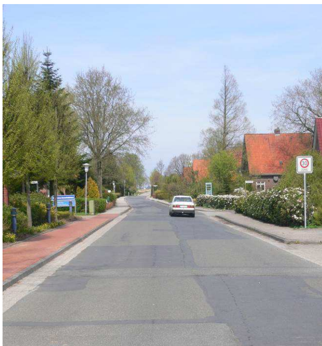
Helmsteder Straße Richtung Bübbenser Tief vor der Umgestaltung
