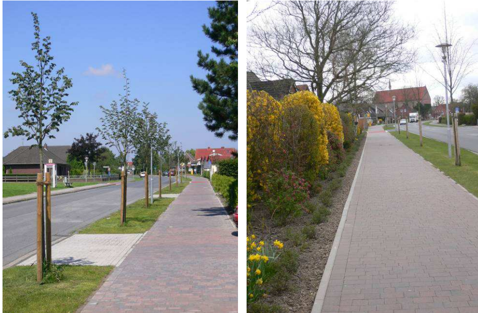
Jeversche Straße, 2.+3. Bauabschnitt
