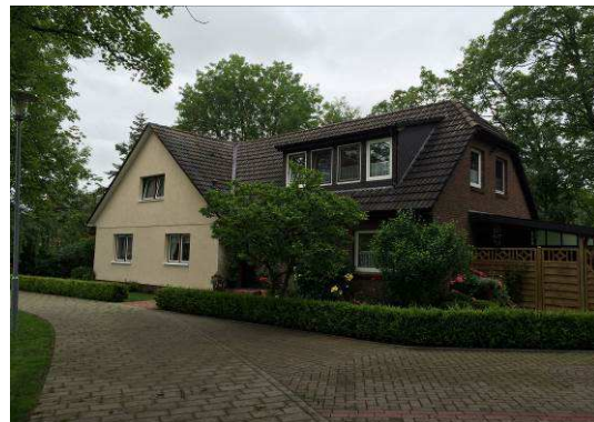
nach der Modernisierung
