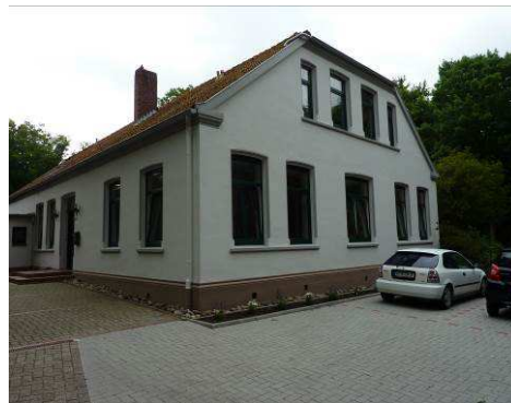
nach der Modernisierung
