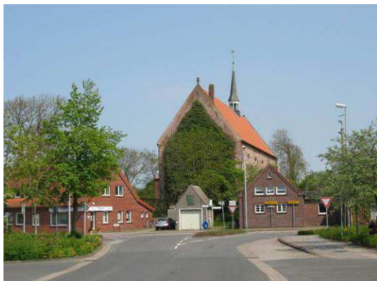
Verstelter Kirchaufgang durch eine Garage
