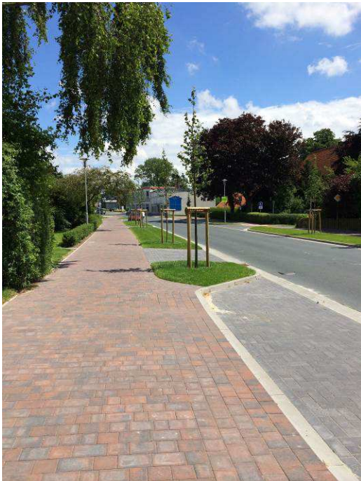
Bismarckstraße nach Neugestaltung der Nebenanlagen
