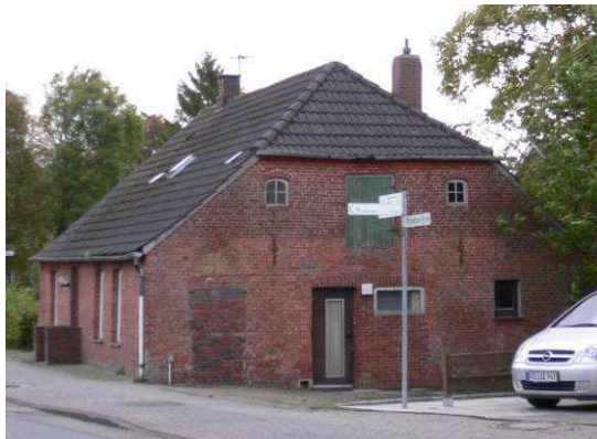
abgängige Bausubstanz Bismarckstraße 19 (2008)
