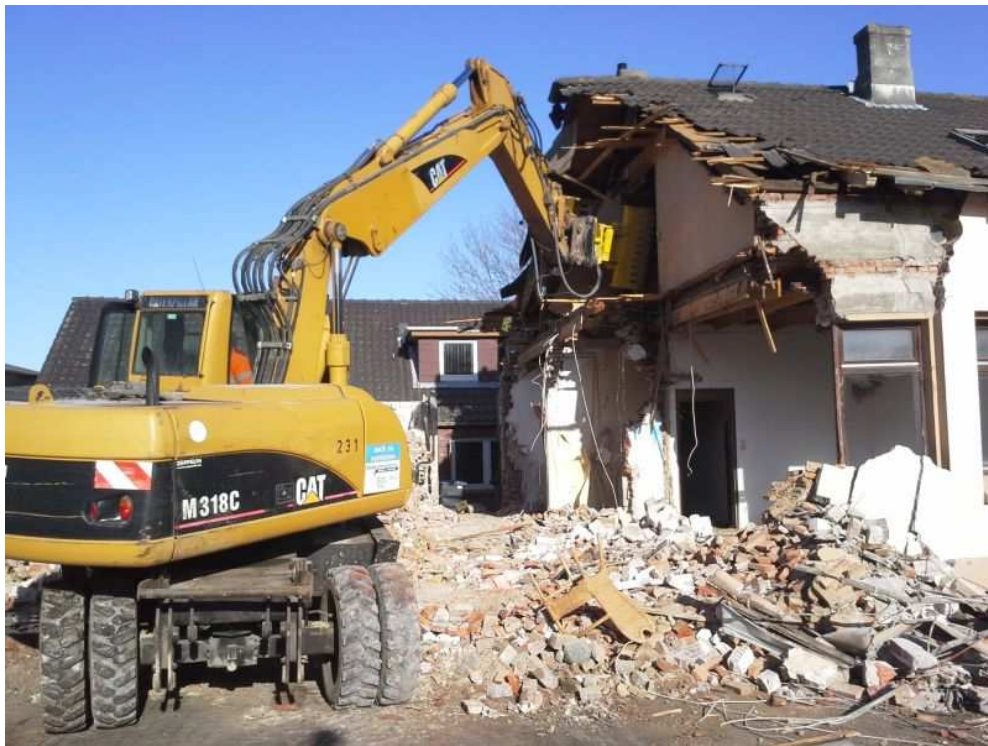
Gebäudeabbruch Jeverische Straße 14
