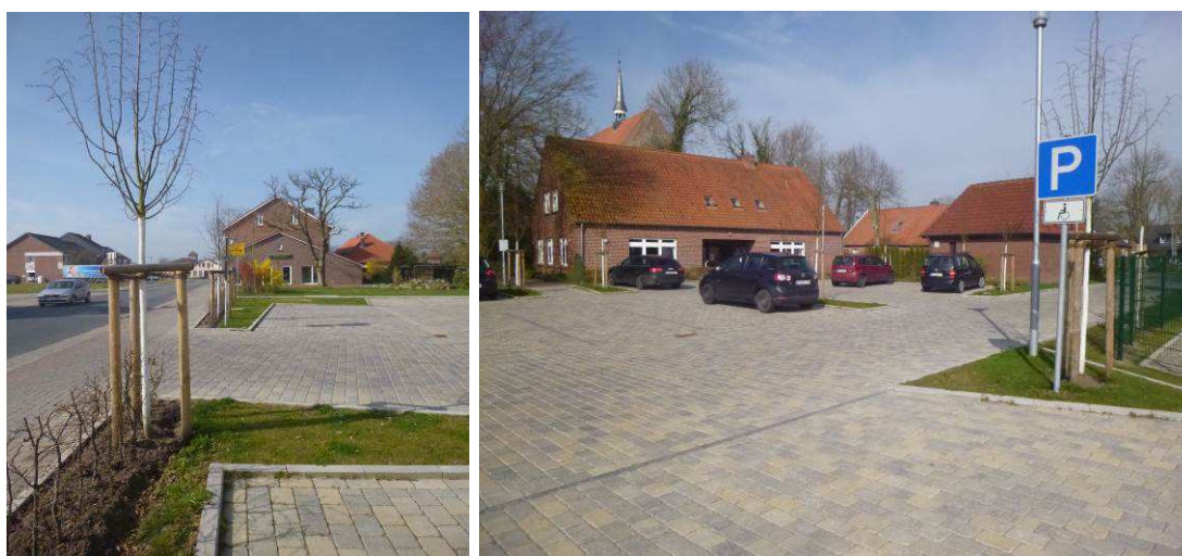
Parkplatz nach Fertigstellung
