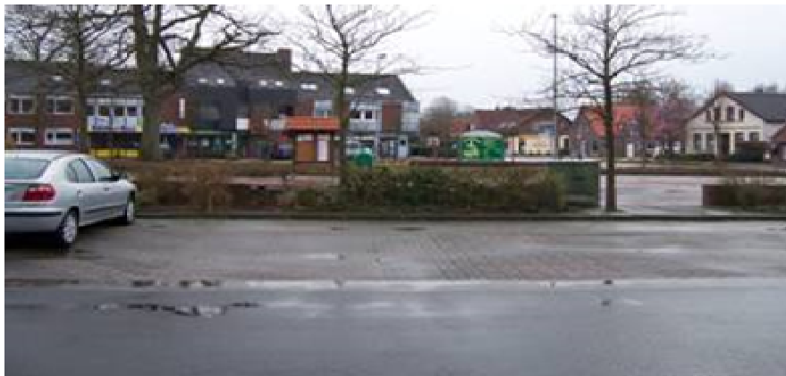
Marktplatz vor Umgestaltung und Verlagerung der Parkplatznutzung
