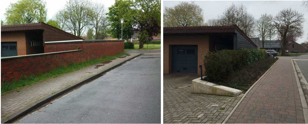
Abbruch Schuppen und Grundstücksmauer Alma-Rogge-Weg/Jeverische Straße 17 (vorher/nachher)
