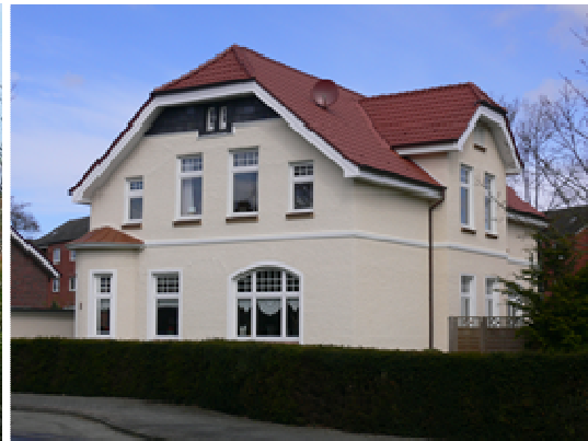
nach der Modernisierung
