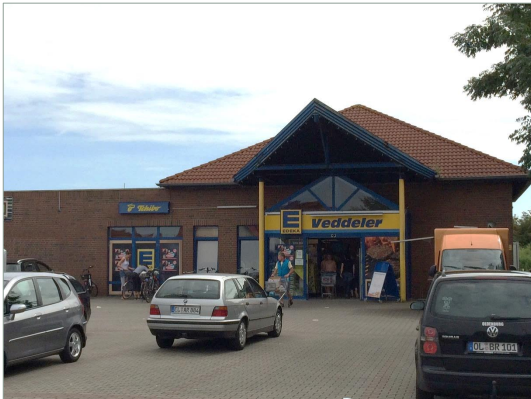
Abbildung 35: Edeka-Verbrauchermarkt am Standort Andelweg in Horumersiel
