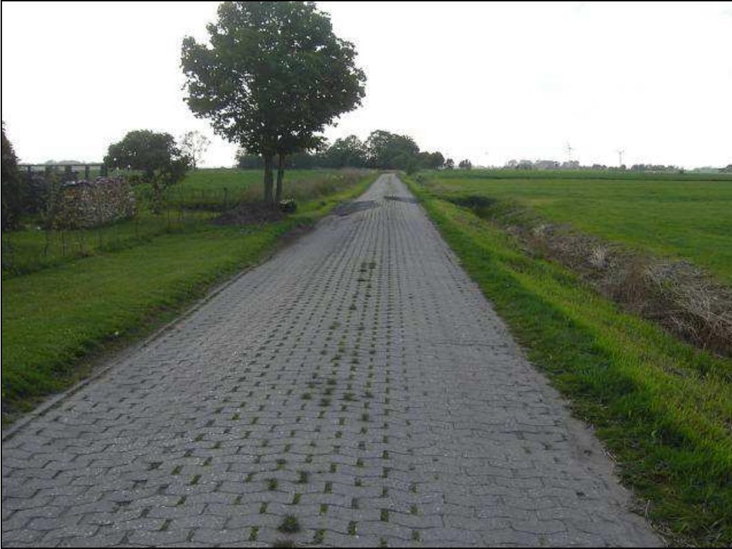
Schlechter noch als der Middoger Weg stellt sich das nordwestliche Teilstück des Müllerweges dar. Hier ist die mit Betonsteinen gepflasterte Straße bereits so stark abgesackt, dass normale Pkw mit dem Bodenblech aufsetzen, wenn die besonders stark deformierten Stellen nicht sorgfältig umfahren werden.
